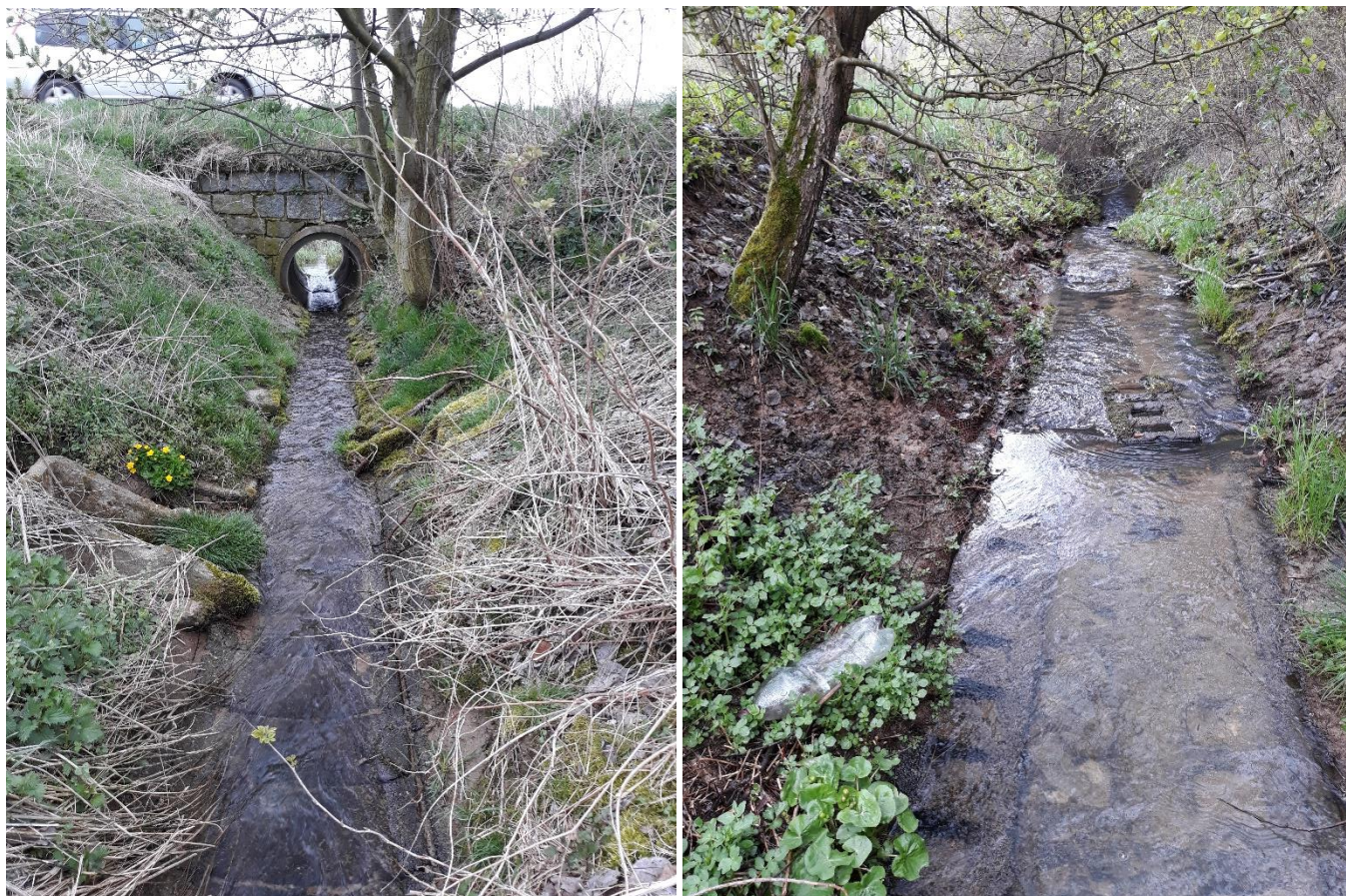
Obr. 20: Žlabovky ve dně a plné betonové tvárnice ve březích vlevo (omezená komunikace s podzemní vodou vlivem technické úpravy), vegetační tvárnice vpravo
