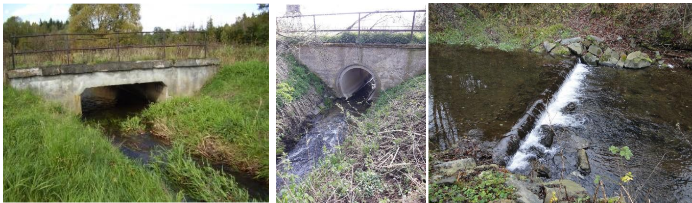
Obr. 41: Rámový propustek (beneš) vlevo, trubní propustek uprostřed, práh z kulatiny ve dně vpravo
