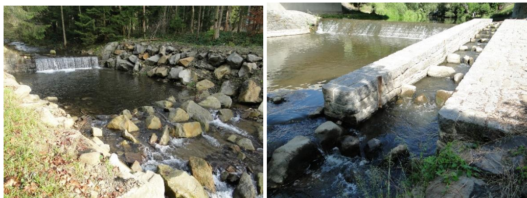
Obr. 42: Zděný stupeň vlevo, jez s rybím přechodem vpravo
