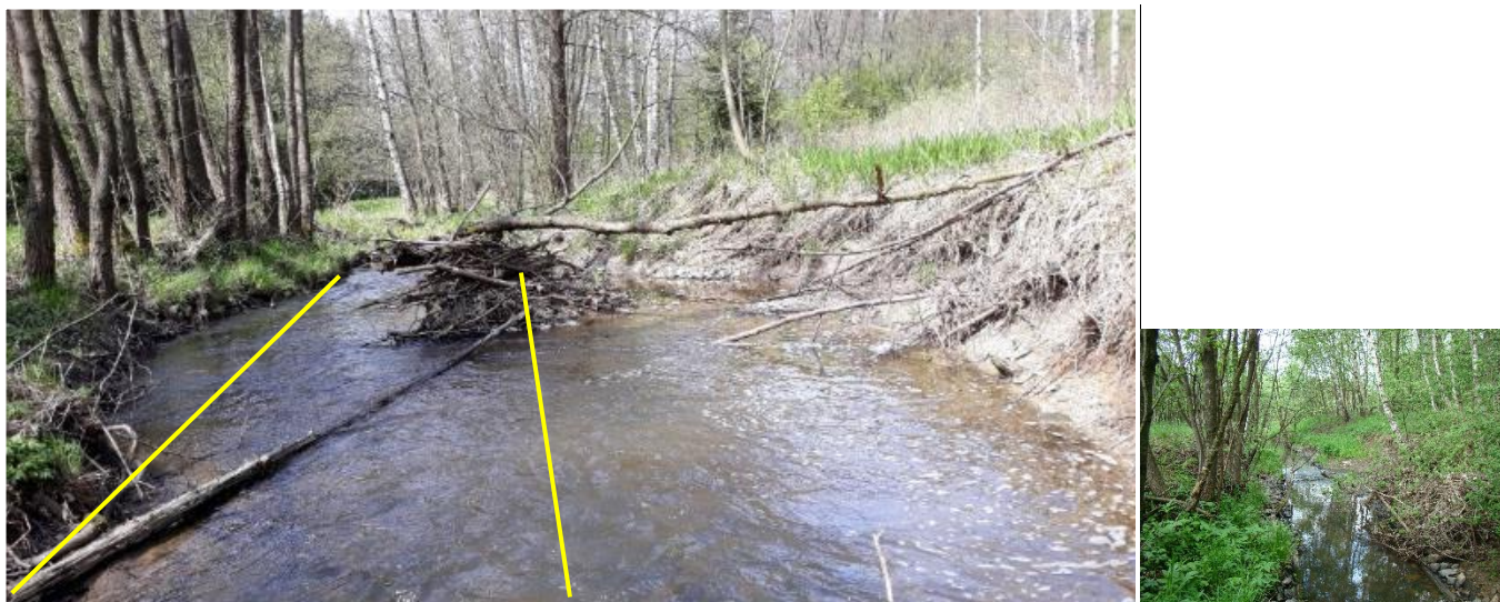
Obr. 31: Působení renaturačních procesů – odnos opevnění břehů kulatinou, výrazné nátrže při pravém i levém břehu a rozvolnění trasy boční erozí, vznik akumulčních tvarů dna a hromadění říčního dřeva; žlutými liniemi naznačena trasa původně opevněného koryta; zároveň se jedná o příklad břehové eroze v souvislosti s pozitivním působením renaturačních procesů (viz parametr 5), na snímku vpravo je stejný profil před cca 12 lety
