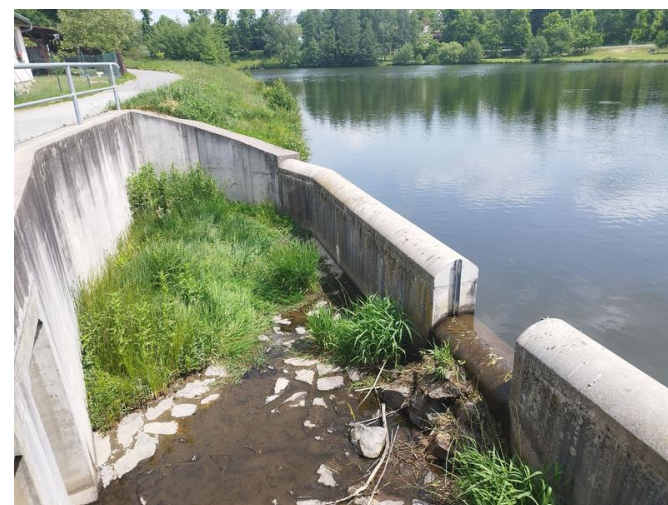
Obr. 4: Bezpečnostní přeliv průchodný pro vydry. Projektant se s požadavkem na zajištění průchodnosti pro vydry vyrovnal tak, že úplně zrušil svislou stěnu pod hranou přelivu a navrhl z čela kašny pozvolný skluz (vlevo). Vpravo - vyrovnaná hromada kamenů v místě pod oknem přelivu činí přeliv obousměrně průchozí. Pokud je průchozí i navazující most pod silnicí, zvířata mohou bezpečně migrovat podél toku, aniž by musela přecházet silnici.
