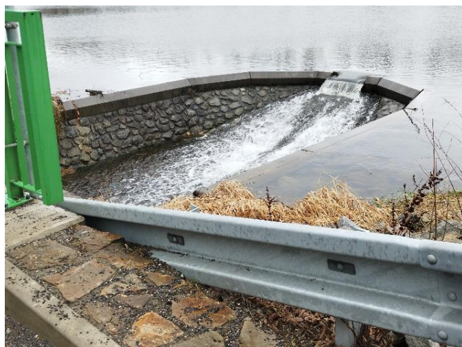
Obr. 4: Bezpečnostní přeliv průchodný pro vydry. Projektant se s požadavkem na zajištění průchodnosti pro vydry vyrovnal tak, že úplně zrušil svislou stěnu pod hranou přelivu a navrhl z čela kašny pozvolný skluz (vlevo). Vpravo - vyrovnaná hromada kamenů v místě pod oknem přelivu činí přeliv obousměrně průchozí. Pokud je průchozí i navazující most pod silnicí, zvířata mohou bezpečně migrovat podél toku, aniž by musela přecházet silnici.
