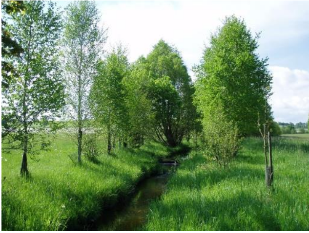
Obr. 23: Vegetační opevnění břehu – zatravnění (vlevo), kulatina (vpravo)
