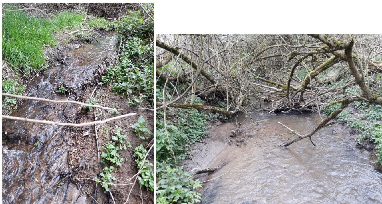
Obr. 30: Působení renaturačních procesů – vlevo překrytí úpravy sedimenty (vegetační tvárnice viditelné ve vzdálenější části snímku), vpravo odnos opevnění břehů betonovými prefabrikáty, úprava dna překrytá sedimenty, akumulace říčního dřeva v korytě a zarůstání koryta dřevinami
