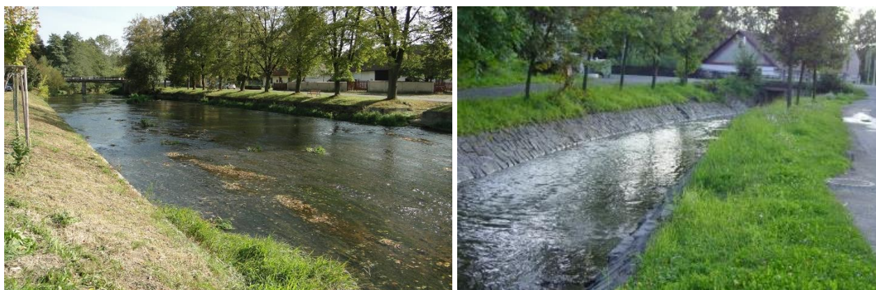
Obr. 36: Vlevo - koryto není nadměrně zahloubené, ale kapacita koryta výrazně naddimenzována (v intravilánu lze takto předpokládat zejména z důvodu protipovodňové ochrany). Vpravo – obdobný příklad, ale zdá se, že ani toto naddimenzování nebude pro povodňové průtoky dostatečné – to lze např. uvést do poznámky.
