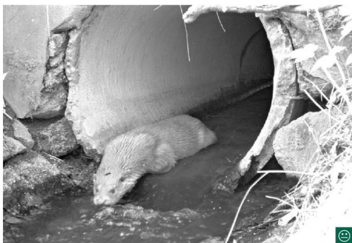
Obr. 50: Trubní propustky s malou hloubkou vody jsou pro vydru průchodné
